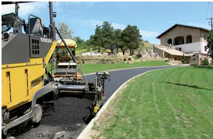
Budování příjezdové komunikace k Penzionu André
