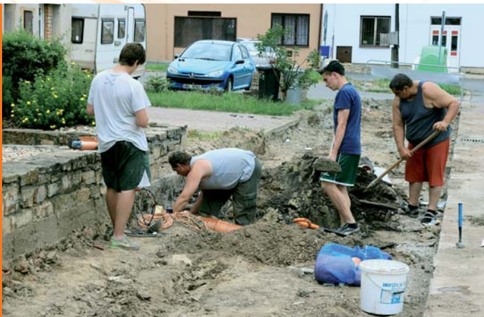
Pokládka potrubí dešťové kanalizace na ulici Ořechová
