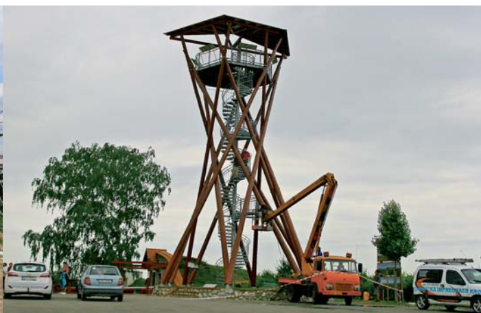
Údržba konstrukce rozhledny Slunečná
