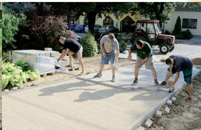
Budování nájezdu ze zámkové dlažby na Hlavní
