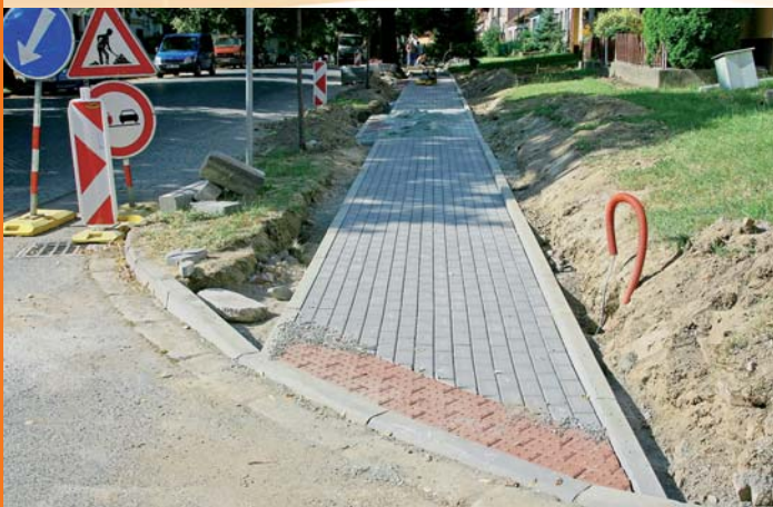
Hlavní ulice – část nového chodníku
