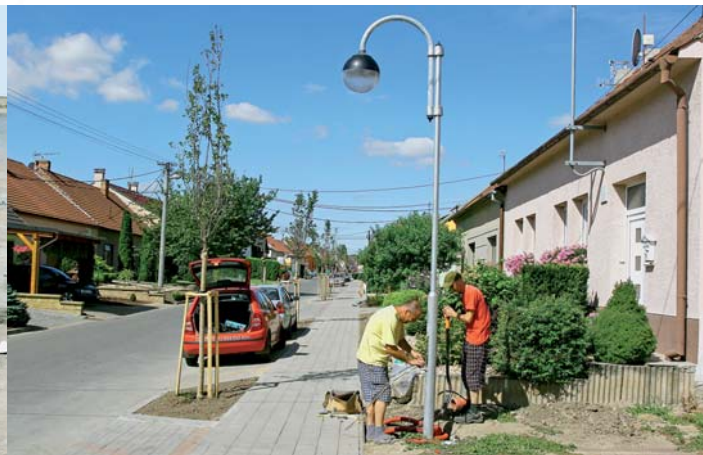
Instalace nového veřejného osvětlení na Ořechové
