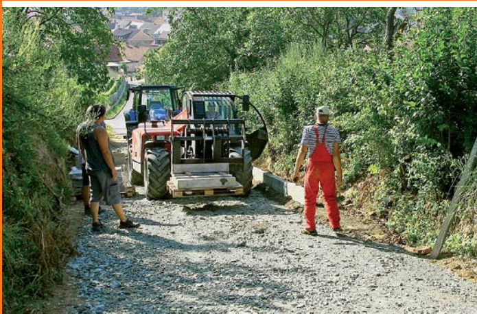
Přípravy k položení hladkého povrchu komunikace na Pajerku
