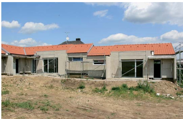
Zhotovení fasády na penzionu pro seniory na ulici Bří Mrštíků
