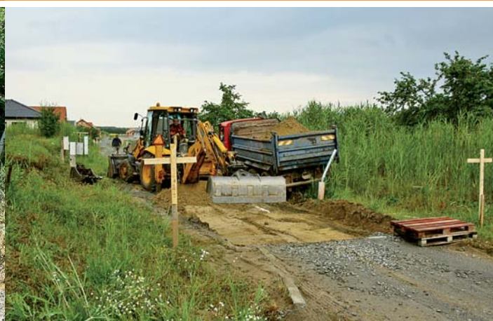
Zahájení budování vozovky na ulici Ostrovecká
